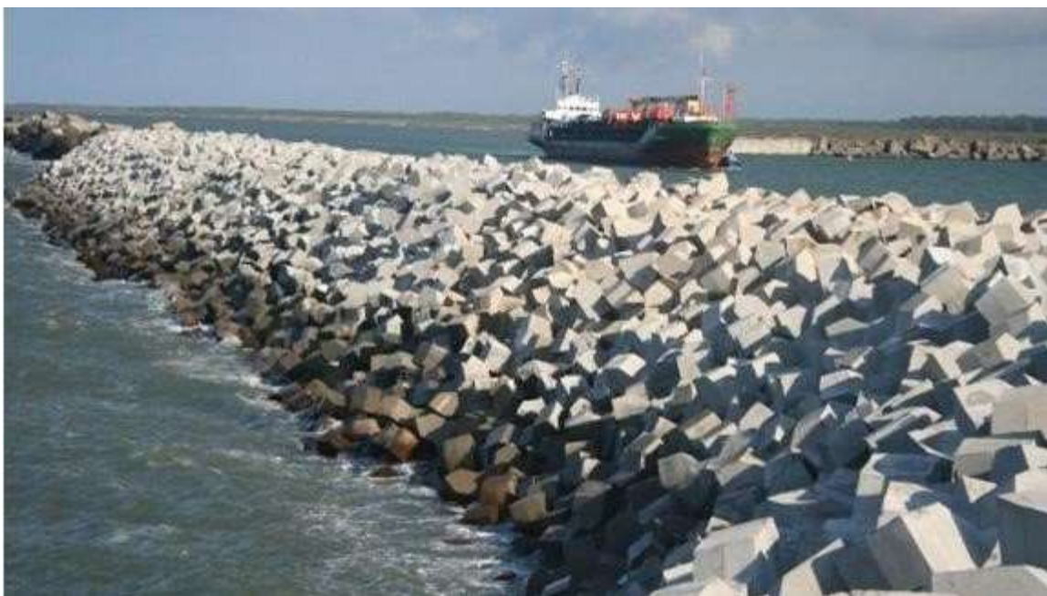
Gambar 8. Alat Penahan Ombak (APO) tipe balok beton Sumber:
